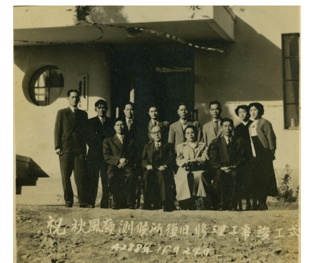
▲추풍령측후소 복구 수리 공사 준공식(1955. 11. 24.)
